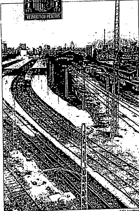
ESTACIÓN. El posible desdoblamiento aún está en estudio.
